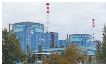
Рис. 42.9. Хмельницька АЕС: 2 атомні енергоблоки потужністю 1000 МВт кожен
