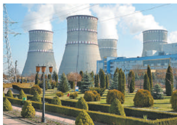
Рис. 42.7. Рівненська АЕС: 4 атомні енергоблоки загальною потужністю 2835 МВт
