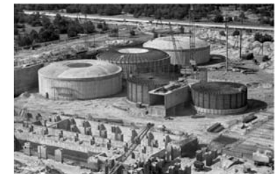
Одна з ділянок будівництва Чорнобильської АЕС, 5 вересня 1975 року. Світлина
