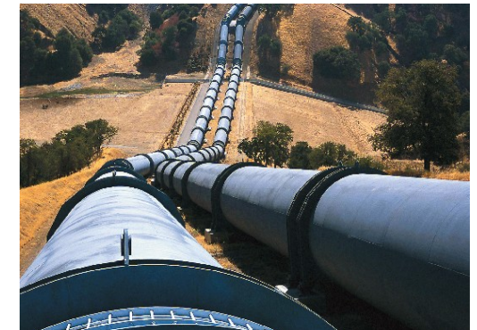
Одна з ділянок газопроводу Дашава – Київ
